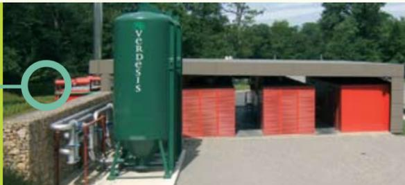
2006 en construisant, à l'entrée du site du Pihourc, une unité qui transforme, après divers traitements, le biogaz en électricité. Divers traitements ? Schématiquement, le biogaz est amené vers la centrale par des conduites. Là, un pré-traitement permet de filtrer certains composés et d'enlever l'eau (qui suit son chemin jusqu'au bassin lixiviat, il n'y a pas de rejet dans la nature). En effet, le gaz est refroidi afin d'éliminer l'eau qui pourrait corroder les moteurs.
